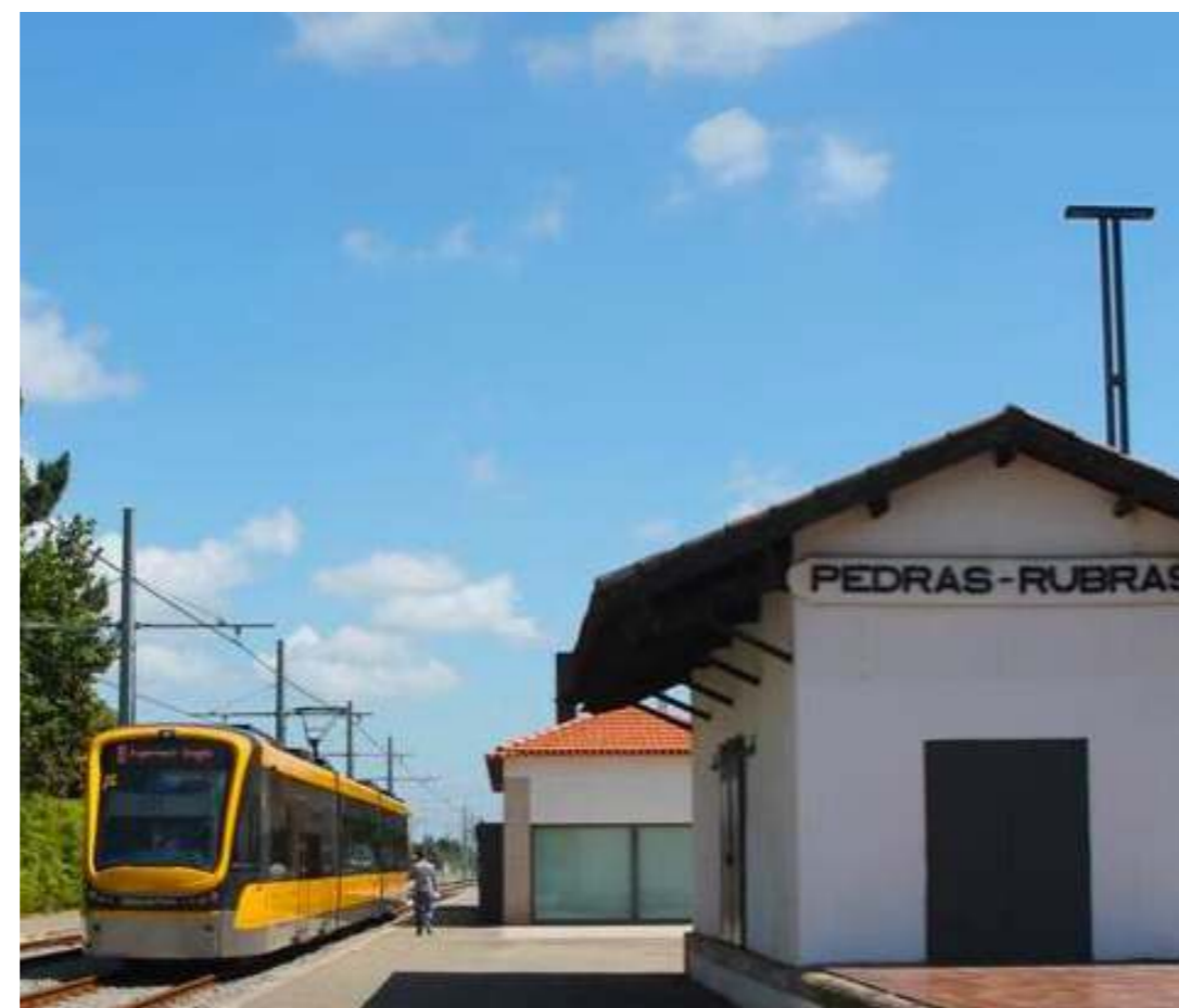
Estação de Pedras Rubras Pedras Rubras Station
